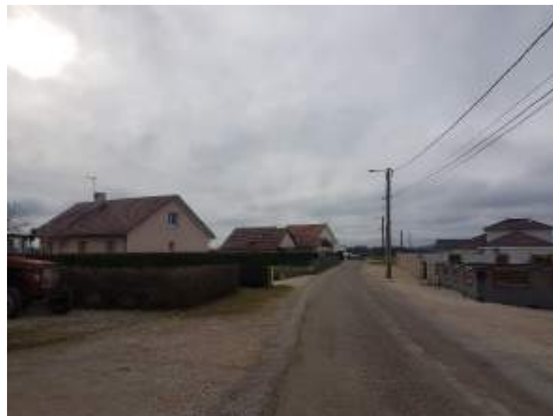
Constructions existantes chemin des Baraques, à l'est du site
